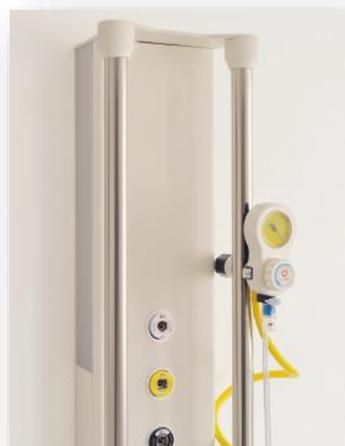
Accesorios como bandejas, cajones, railes auxiliares, caudalímetros, vacuorreguladores,...se adaptan fácilmente a los tubos verticales mediante bridas desmontables, permitiendo un rápido cambio.
